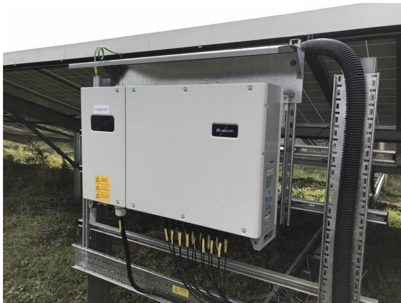
Slika 2: Detalj montaže izmjenjivača na podkonstrukciju
