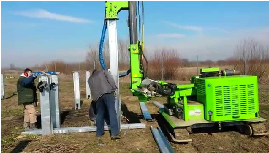
Slika 3: Prikaz stroja za zabijanje stupova u zemlju
